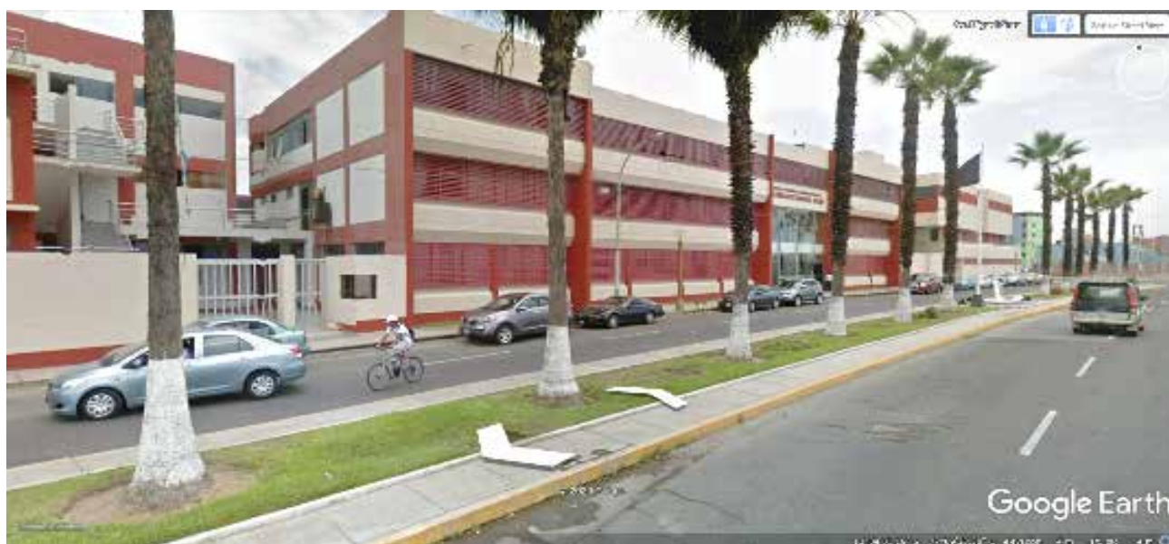
Vista externa de las instalaciones de la Escuela Nacional de Marina Mercante "Almirante Miguel Grau"
